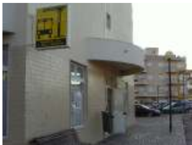
FIGURA 7.12 – TERMINAL RODoviÁRIO DE SÃO BRÁS DE ALPORTEL – ZONA EXTERIOR
