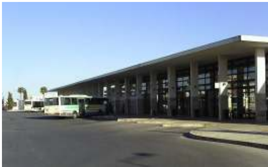
FIGURA 7.2 – TERMINAL RODOVIÁRIO DE ALBUFEIRA – ZONA EXTERIOR
